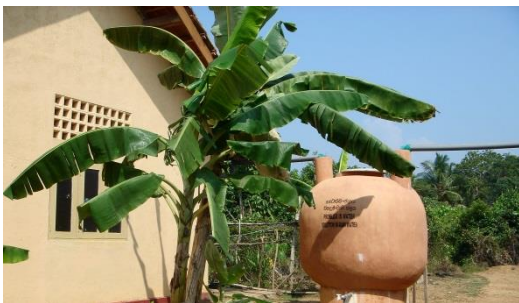
Sistema recolector de agua pluvial en Sri Lanka
